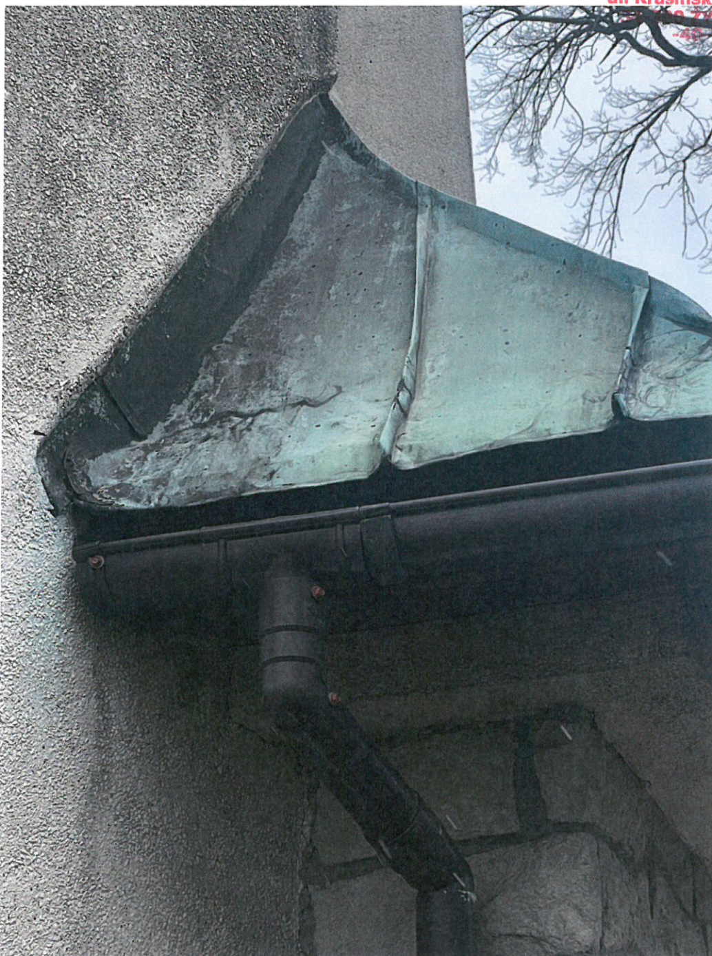
Fot. nr 28 Kościół p. w. św. Marcina w Radziechowach, k. XIV/XV w. Fragment zadaszania kaplicy Ogrójca. Widoczna korozja i nieszczelności blachy.
