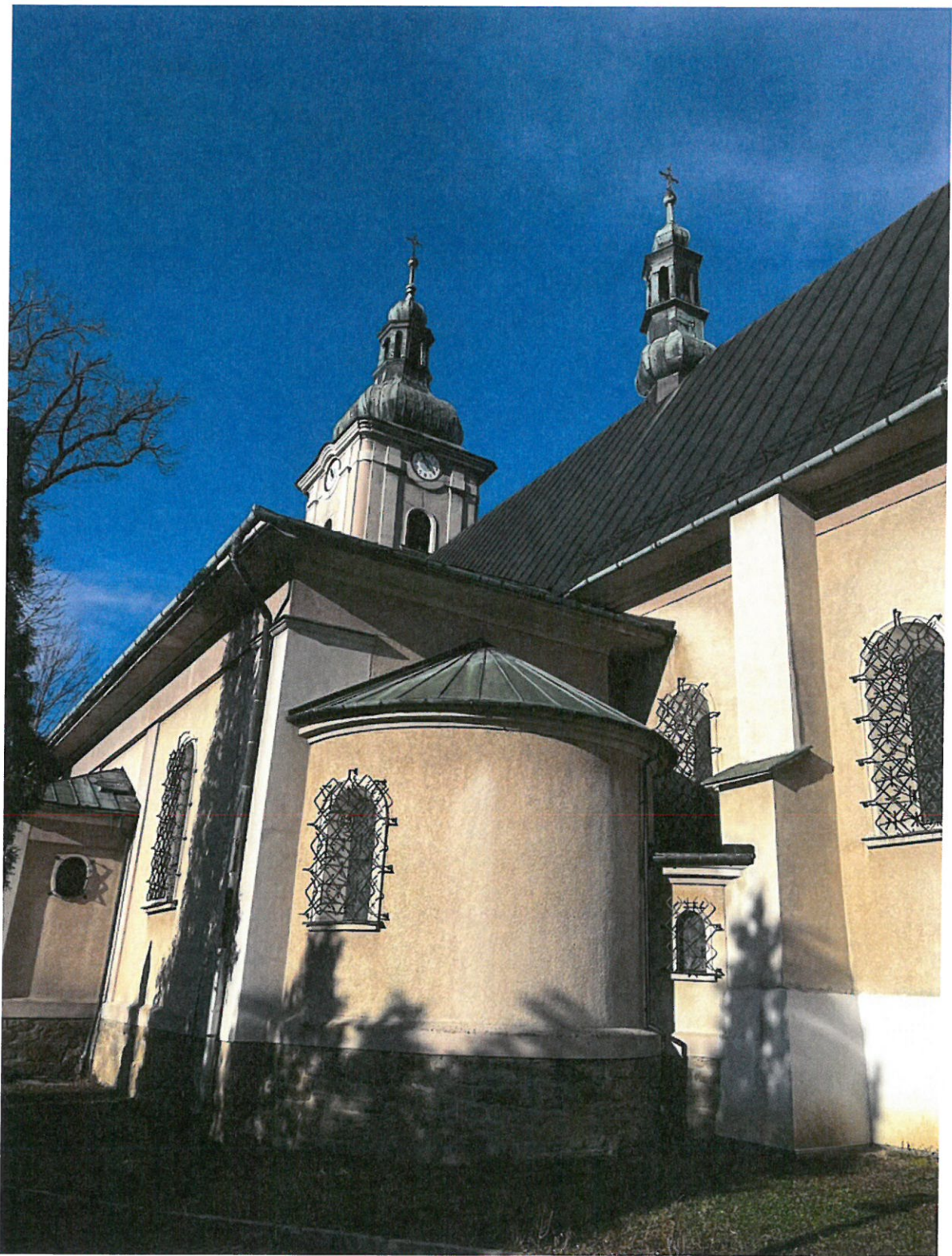
Fot. nr 13 Kościół p. w. św. Marcina w Radziechowach, k. XIV/XV w. Widok ogólny od strony południowej.
