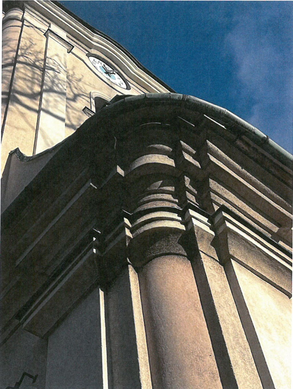
Fot. nr 19 Kościół p. w. św. Marcina w Radziechowach, k. XIV/XV w. Widok ogólny od strony południowej.
