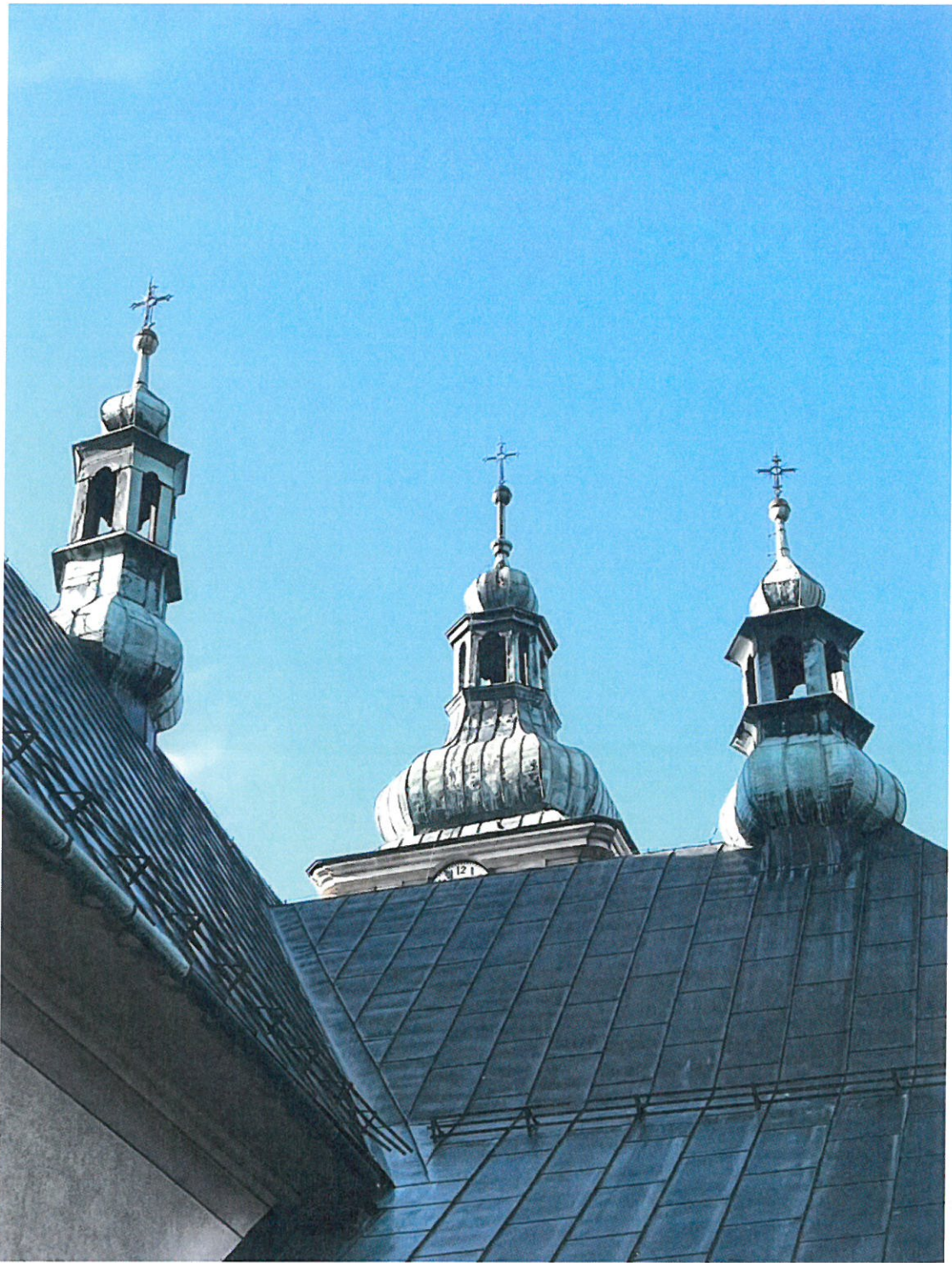
Fot. nr 12 Kościół p. w. św. Marcina w Radziechowach, k. XIV/XV w. Widok wieżyczek na sygnaturki ze zwieńczeniami w postaci kul i krzyży.
