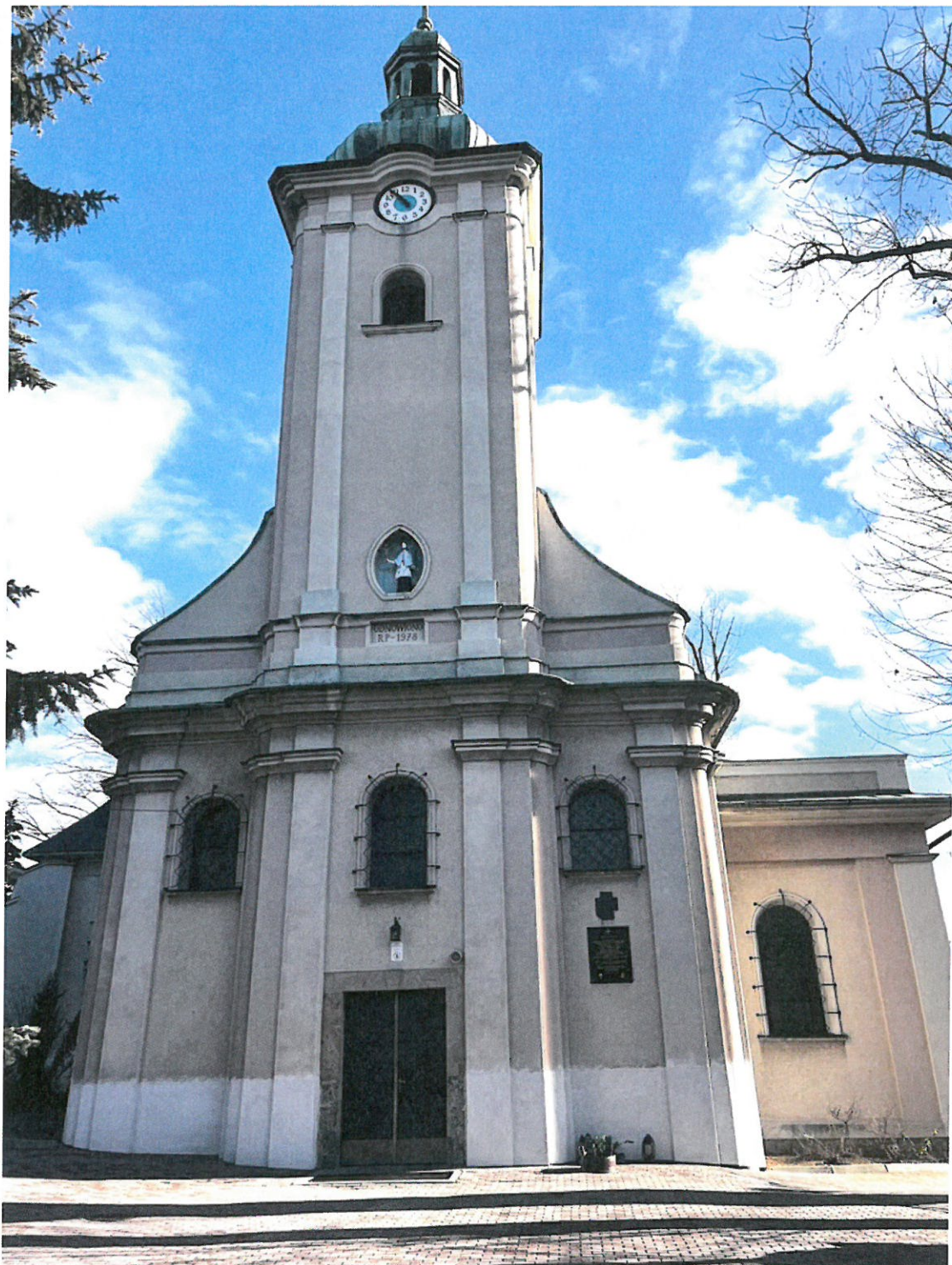
Fot. nr 1 Kościół p. w. św. Marcina w Radziechowach, k. XIV/XV w. Fasada, widok ogólny od strony zachodniej. Widoczne tynki renowacyjne w strefie cokołowej wykonane w ramach wcześniejszego remontu.
