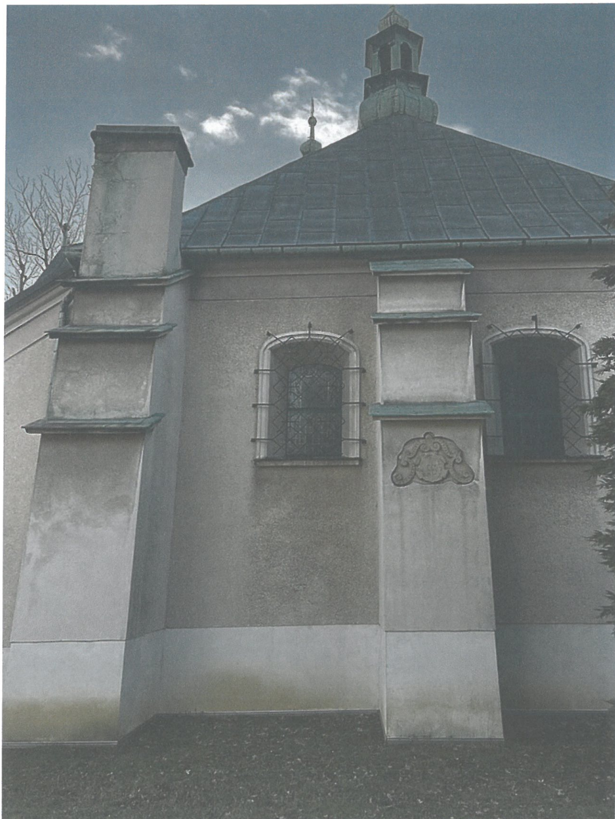
Zdjęcie 6. Widok na część elewacji północnej z kamiennym kartuszem
